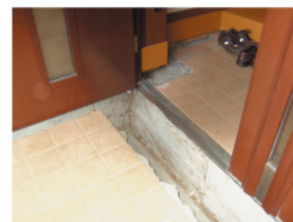
玄関部分の被害 断熱材撤去後の蟻道痕と家屋への浸入被害状況
