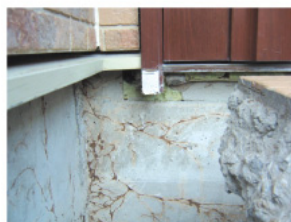
玄関の被害、断熱材撤去後の蟻道痕
